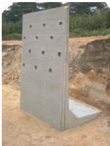
Het plaatsen van het eerste element.
