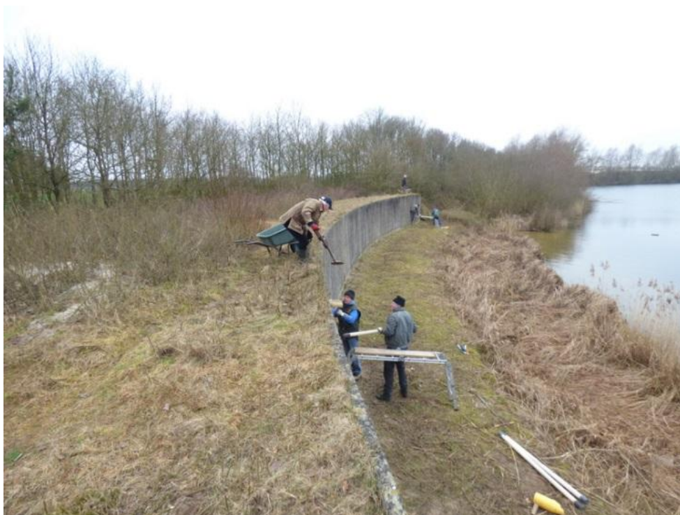
De wand wordt zwaluwklaar gemaakt
