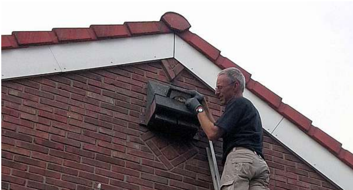
De succesvolle zolderverdieping aan de Oranjestraat
