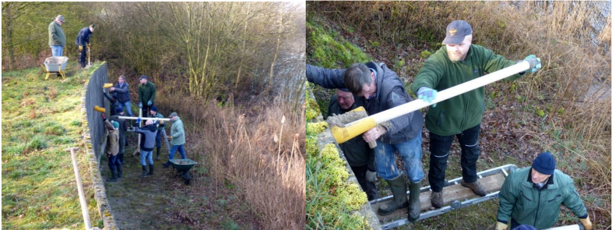
De harde werkers van bovenaf gezien
