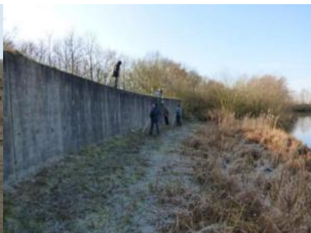
Onderhoud aan de betonnen wand
