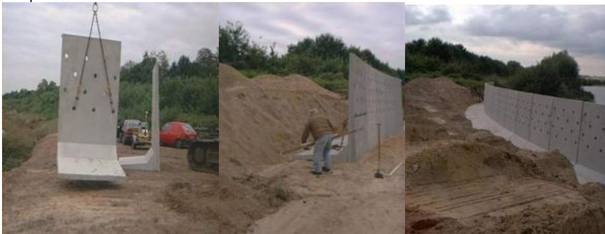
Bouw oeverwaluwand Oelemars bij Losser (foto's Sander Wansing)
