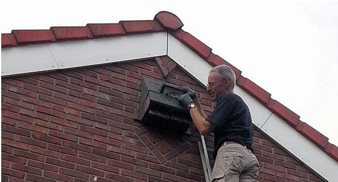
De succesvolle zolderverdieping aan de Oranjestraat
